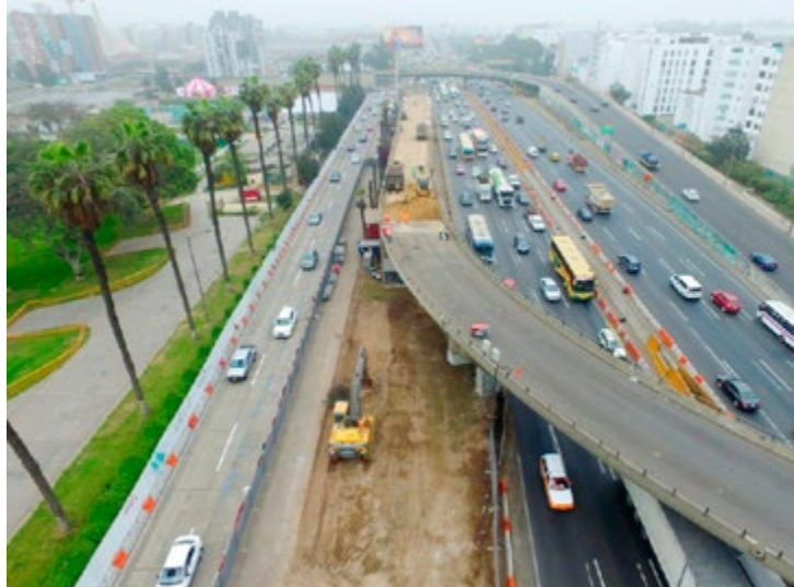
Vista aérea de las obras para la construcción del nuevo bypass del Derby, que beneficiará a más de 676 000 residentes. Foto: Municipalidad de Lima.
